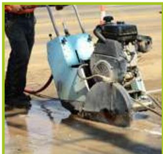
Tronçonneuse avec système d'abattage à l'humide - enrobés
